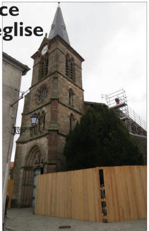
Des bardages ont été mis en place autour de l'église pour sécuriser les échafaudages. Photo RL
