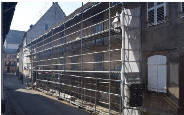
Les écuries seigneuriales en cours de restauration. Vous pouvez faire des dons qui pourront être en partie déduits. Photo RL.
