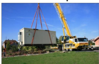
Mise en place d'un poste NRO derrière la salle polyvalente. Photo: RL.
