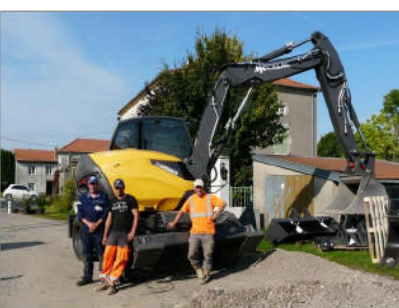
Les ouvriers sont fiers de cette toute nouvelle machine dont ce sont les premiers coups de godet. Photo RL.
