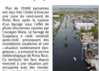
Le barrage de Guajataca, qui a cédé, a provoqué d'importantes inondations. Photo AP
