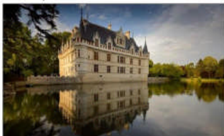
Les façades de tuffeau blanc ont été nettoyées et les décors sculptés restaurés. Photo © Léonard de Sarno - Centre des recherches et des archives
