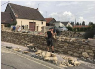
Les maçons en plein travail.
