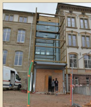
Ce joli chantier de quelque 4,9 M€ s'apprête à ouvrir ses portes au public. Photo RL
