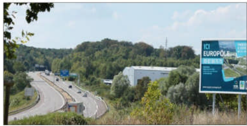
Les travaux auront lieu à partir du 28 août et jusqu'au 20 octobre sur un tronçon de deux fois 20 km entre l'échangeur de Sarreguemines (photos) et Freyming. (Photo Thierry NICOLAS)
