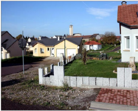
A Roussy-le-Village, les réseaux et les canalisations n'ont pas été enfouis à la profondeur réglementaire dans le lotissement Les Vergers. Photo Anthony PICHÉ
