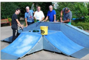
Les ouvriers communaux et les adjoints au maire finissent la remise en état des structures. Photo: RL
