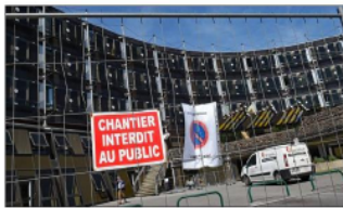
Le chantier de rénovation du tribunal de Nancy a débuté en 2016. Photo: DR République/Colin JACQUOT
