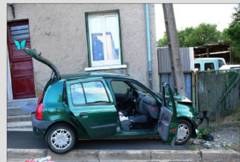
La voiture s'est encastrée dans le poteau. La violence du choc était telle, que la base de ce dernier s'est brisée. Photo RL.
