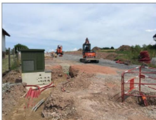
La future rue des Genêts avec, au premier plan, le nouveau transformateur. Photo: RL
