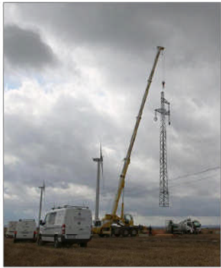
Le lavage de certains pylônes s'effectue à quelques dizaines de mètres seulement des éoliennes. Photo Stéphane STYTER
