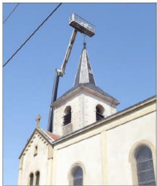
Quelques petits travaux ont été réalisés sur le clocher : mise hors eau, changement de planches de rive, etc. Pour autant, l'utilisation de la grue s'est avérée indispensable pour permettre aux ouvriers d'accéder à leur chantier. Profitant de la mobilisation de cette machine, un nettoyage de la façade a également été réalisé.
