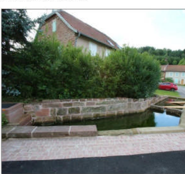
Le lavoir de Lafimbolle a bénéficié de ces travaux.
