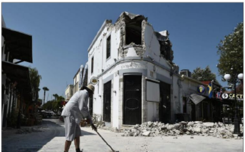
À Kos, le séisme a provoqué des dégâts sur les vieux bâtiments. Photo AFP
