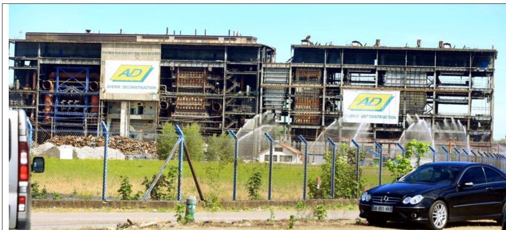
Le squelette métallique de la centrale avant que l'on appuie sur le bouton.
