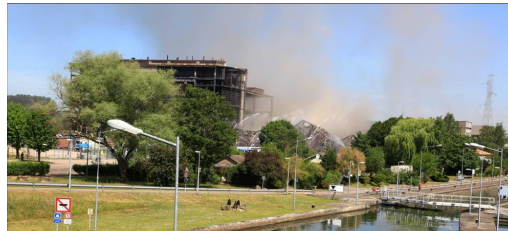
Mettre 7 000 t de métal à terre n'a pris que quelques secondes.
