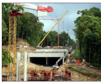
L'ouvrage du tram du Kirchberg. Photo archives RU/ Pierre HECKLER
