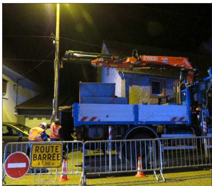
Le camion-grue a permis de stabiliser le poteau avant de retirer la voiture encastrée. Photo RL
