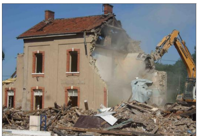
L'ancienne gare de Château-Salins, un des morceaux du patrimoine perdu de la commune. Photo RL
