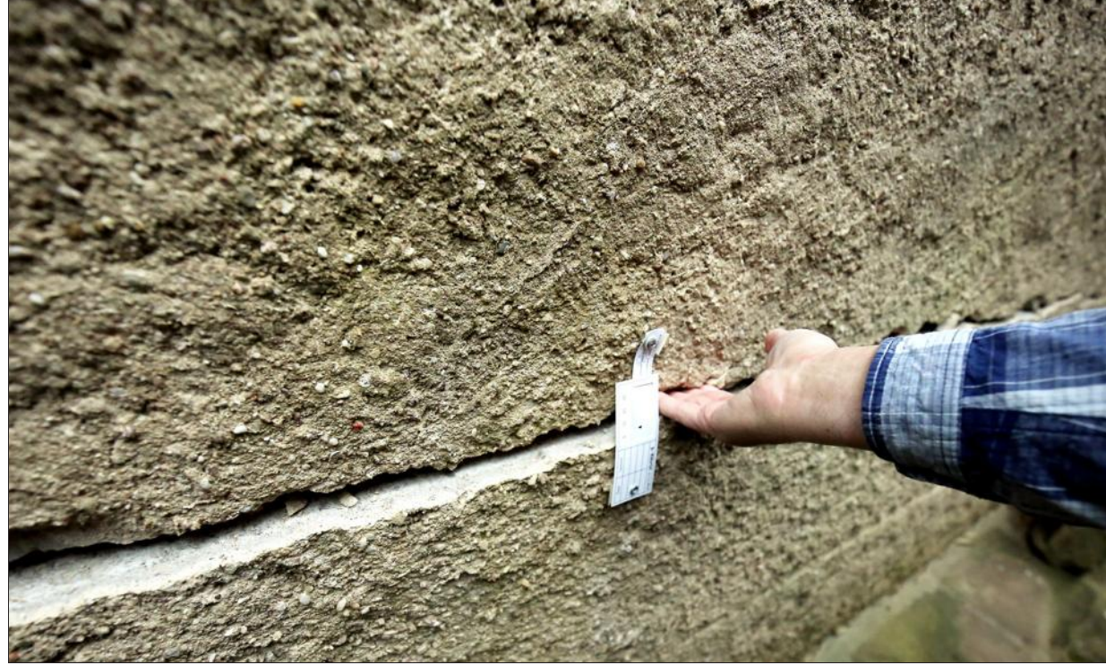
Comme ici à Plappeville, des fissures sont apparues sur de nombreuses façades de maisons, après la sécheresse de 2015. Photo Marc WIRTZ
