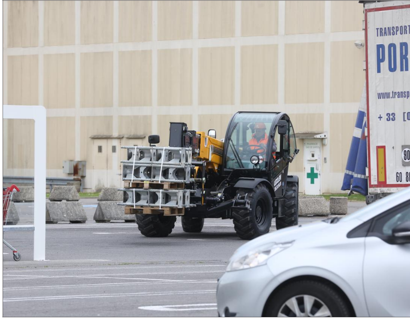
Ces tubulures sont utilisées à l'édification de huit tours destinées à soutenir la charpente dans la zone fragilisée. Photo Gilles WIRTZ
