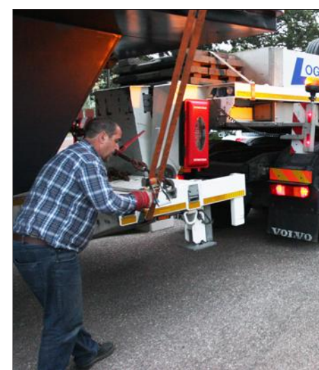
La structure a dû être attachée avec de larges sangles pour assurer son levage.
