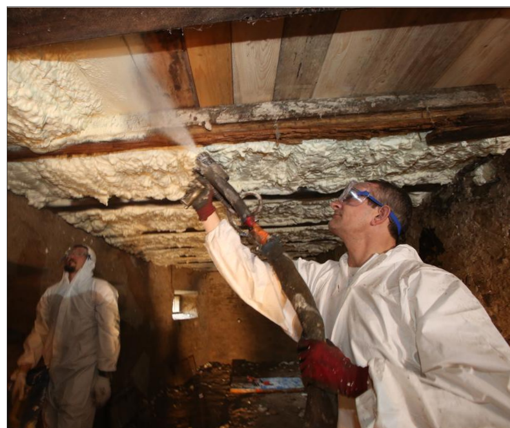
La projection des deux produits chimiques, qui se neutralisent, se fait sans protections particulières. La mousse se forme instantanément, ici dans un vide sanitaire. Après ventilation, aucune émission nocive n'est à craindre dans l'habitation. Photo Laurent MAMI
