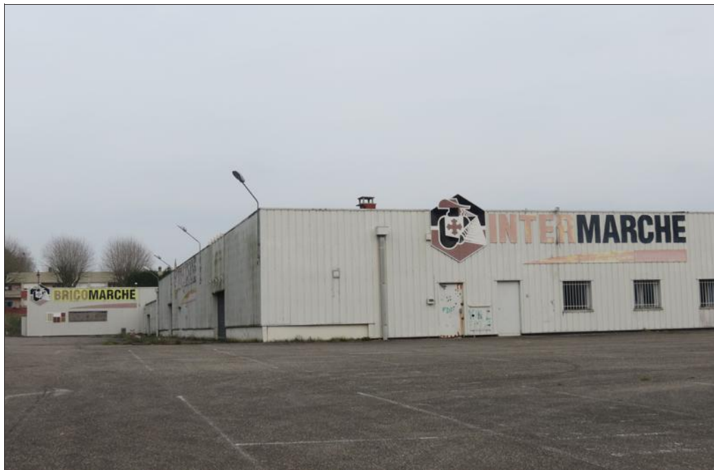
L'ancien magasin Intermarché et ses terrains ont été achetés par la municipalité pour 80 000 €. Photo RL.
