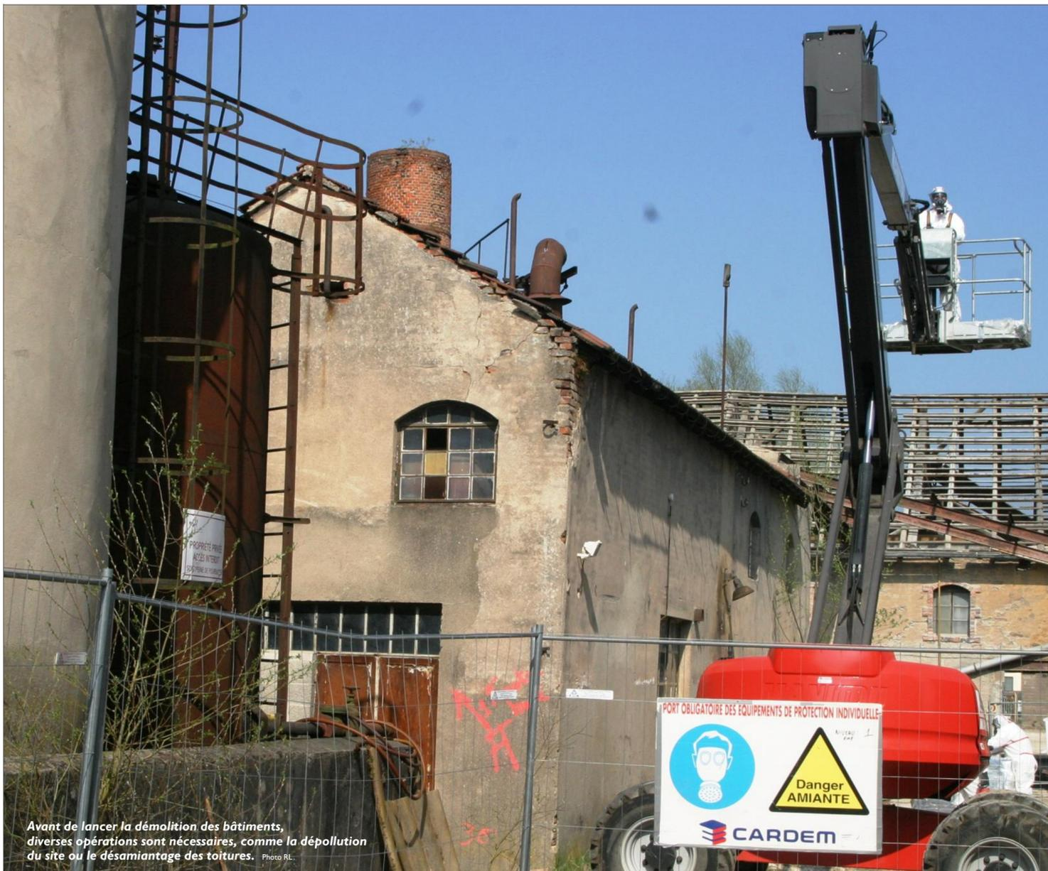
Avant de lancer la démolition des bâtiments, diverses opérations sont nécessaires, comme la dépollution du site ou le désamiantage des toitures. Photo RL.
