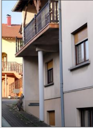
La rambarde du balcon a cédé alors que le couple s'y adossait. Photo RL
