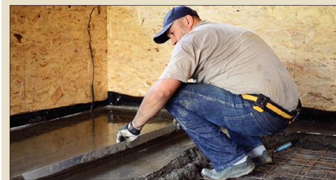
La réalisation d'une chape de ciment permet d'obtenir un sol plan et sans défauts.
