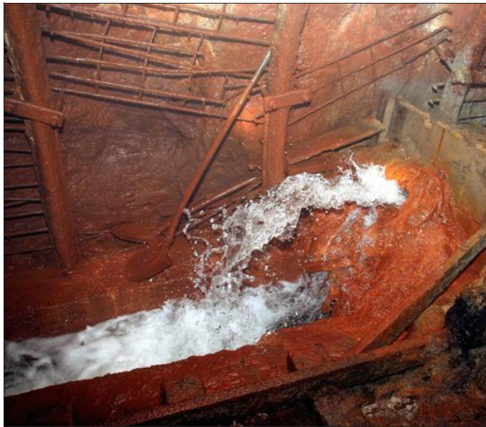
L'objectif est d'utiliser les eaux d'exhaure, liées à l'ennoyage des mines, car elles sont naturellement chaudes.
