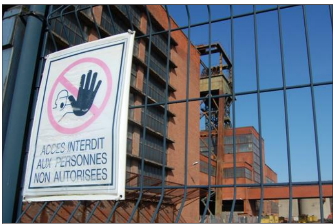
Si l'ancien carreau de Petite-Rosselle accueille des visiteurs, notamment au musée de la Mine, une vingtaine de bâtiments du site restent interdits au public car très dangereux. Photo RL
