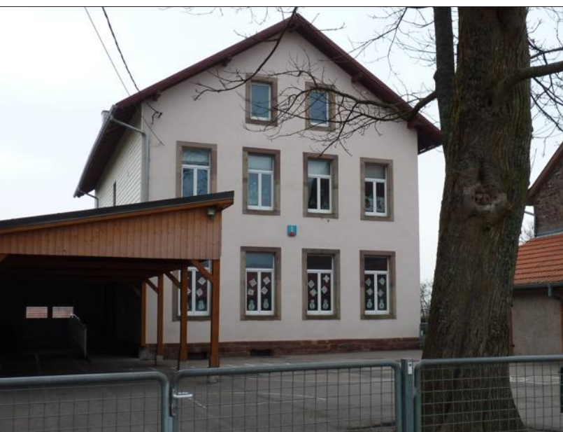
La toiture de l'école maternelle ainsi que l'isolation des combles et de la façade extérieure ont fait l'objet de demande de subvention. Photo RL
