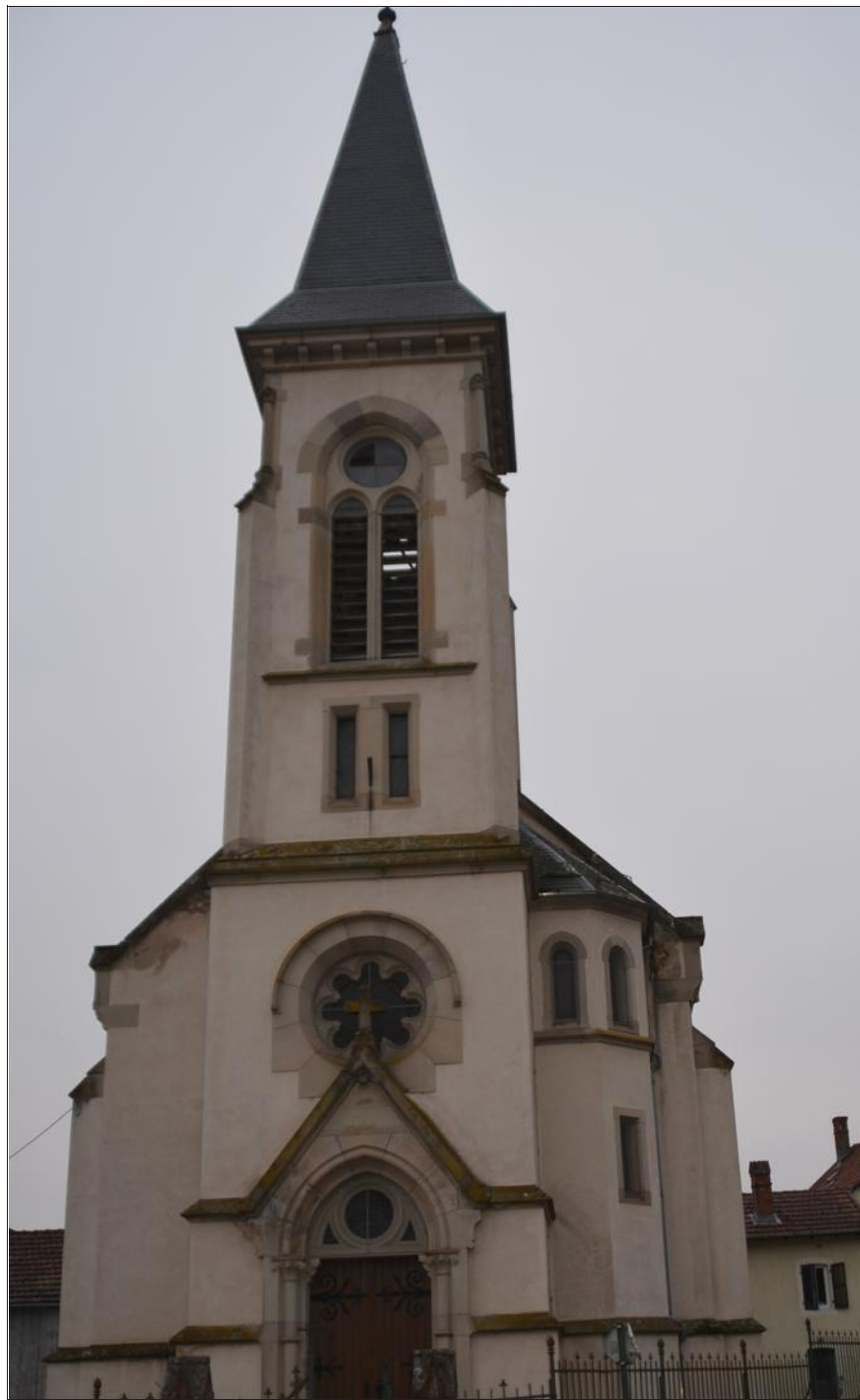
D'importants travaux d'étanchéité sont prévus au temple. Photo RL
