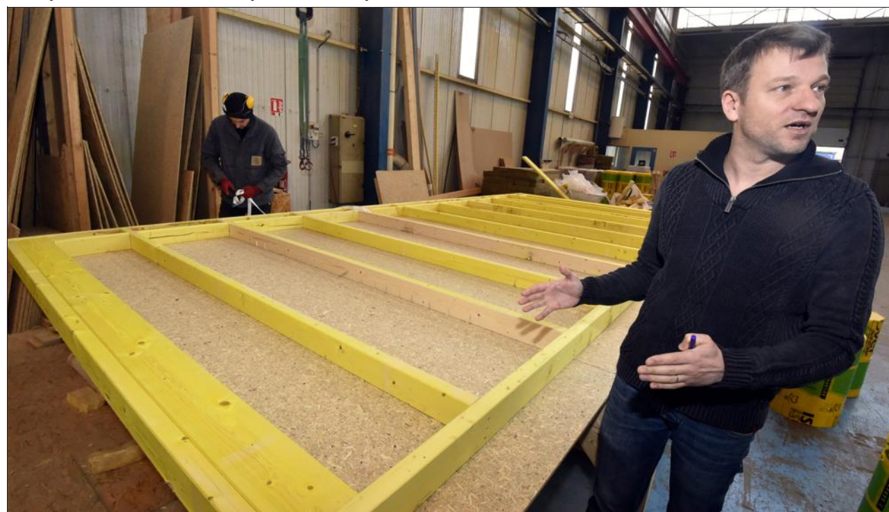
En sept ans, Julien Hocquard et son entreprise Passiv'home ont construit une centaine de bâtiments, dont une soixantaine qui répondent aux standards du passif et une dizaine qui sont certifiés. Photo Eric THIEBAUT
