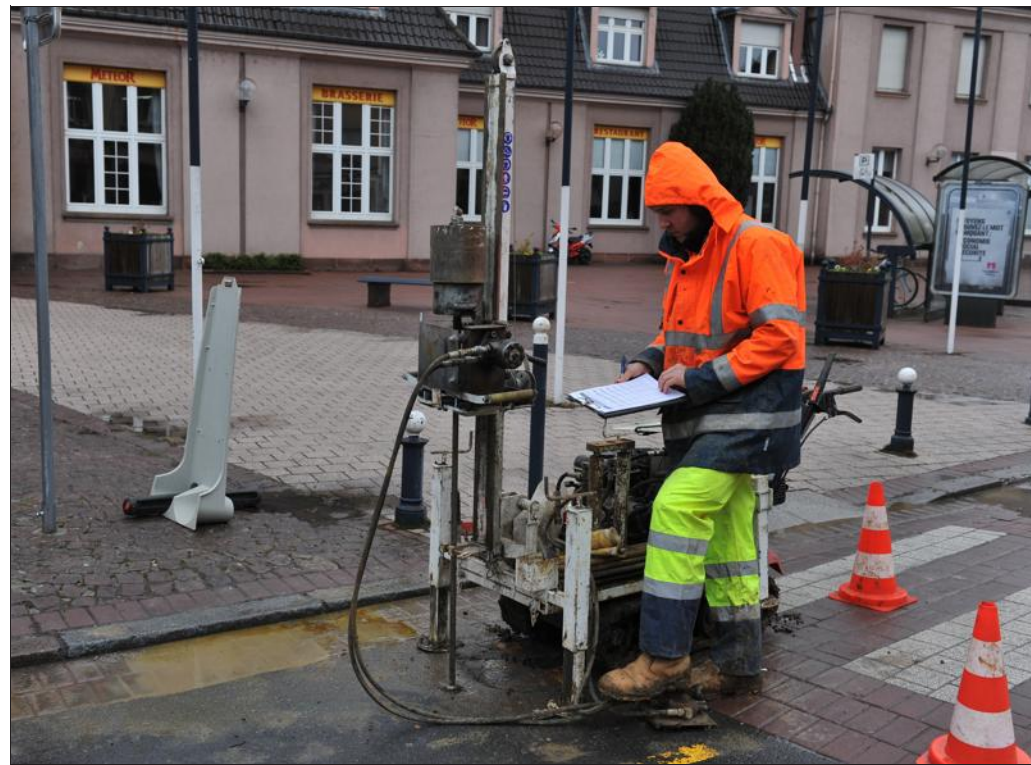
Après des sondages à la pelle où s'élèvera le parking paysager, des sondages et des tests de la résistance de la chaussée ont eu lieu aux abords de la gare. Photo RL
