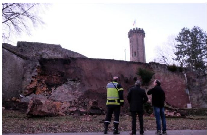
Un morceau du mur, d'une vingtaine de mètres de long sur une dizaine de mètres de haut, s'est effondré. Photo RL
