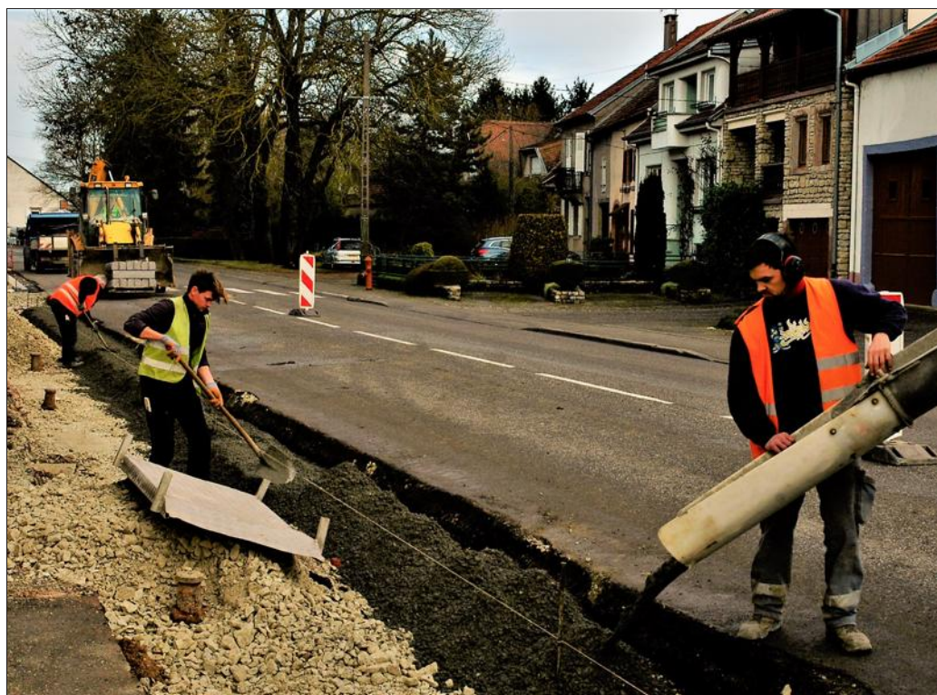
Les ouvriers de l'entreprise Rauscher sont à l'œuvre. Le chantier avance à une bonne allure. Photo RL.
