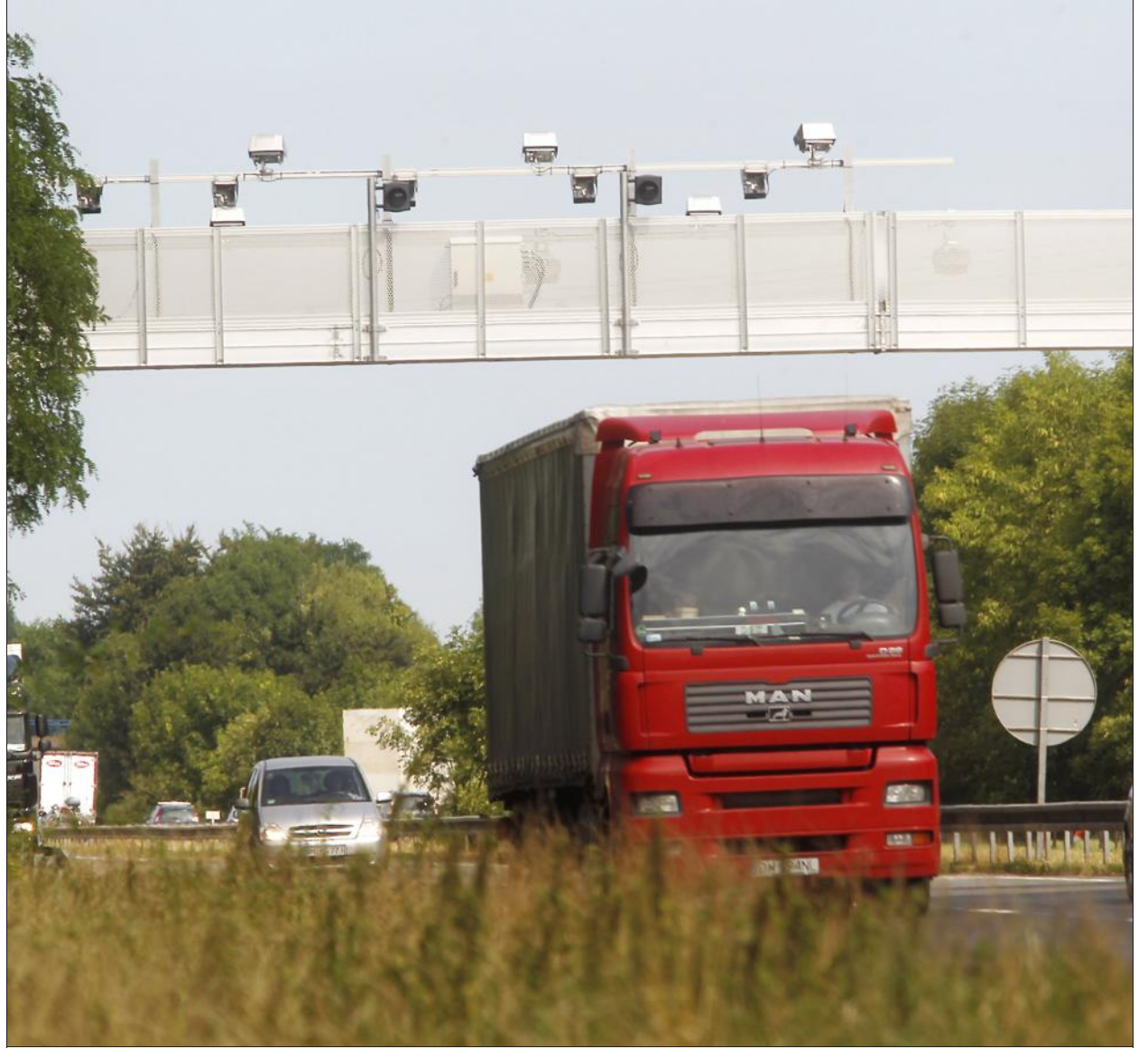
La grande majorité des portiques installés pour l'écotaxe sont restés en place. Photo archives RL/Mary GOLLIN
