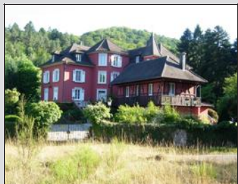
Château de la Vieille Fonderie. Photo RL
