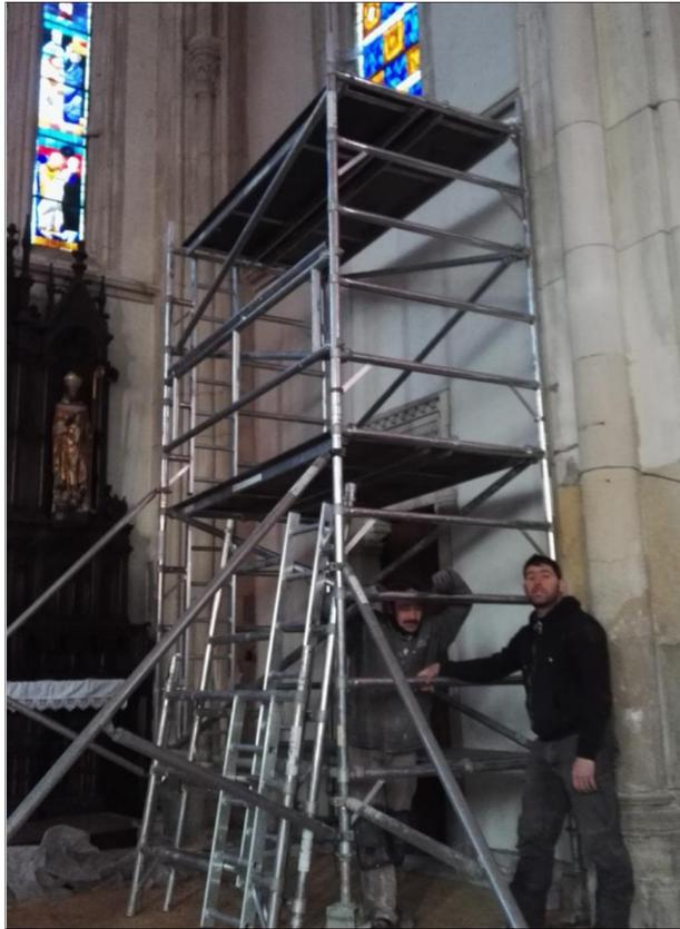
Les travaux de jointoiment sont en cours au-dessus de la sacristie. PHOTO RL
