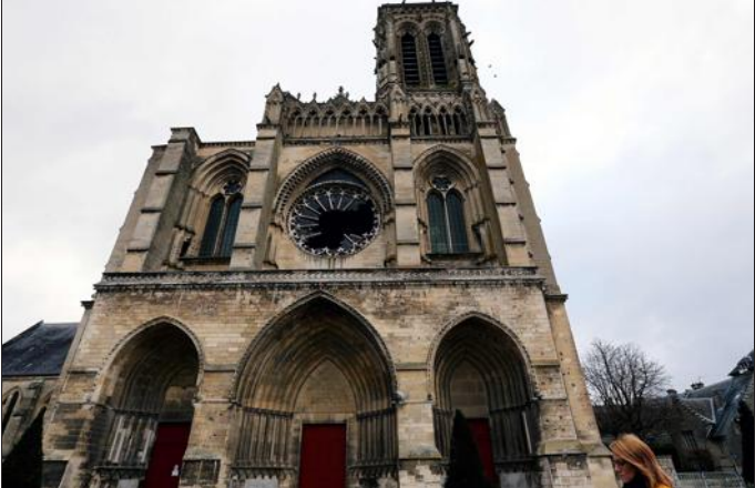
La rosace de la cathédrale de Soissons (Aisne) a littéralement explosé sous la pression du vent. Les débris de pierre et de vitrail ont endommagé le grand orgue de l'édifice. Photo AFP
