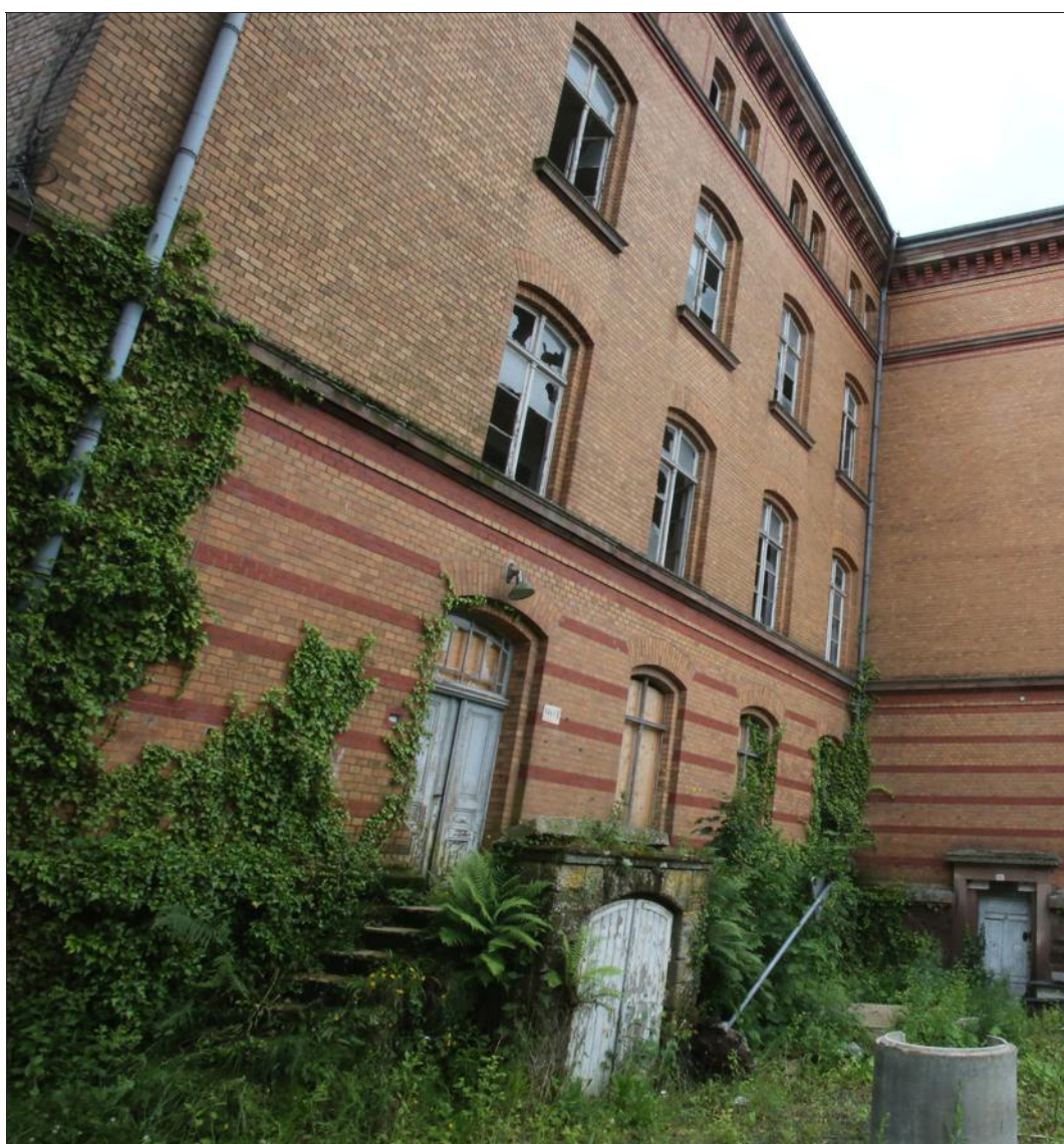
Ce bâtiment est le dernier de l'ensemble formé par l'ancien hôpital militaire de Sarrebourg, au quartier Gérôme. Il était plus principalement dédié à l'administration.
