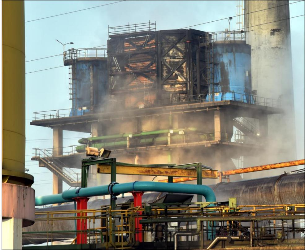
Le feu a débuté au cœur du site sidérurgique au cœur des installations de la cokerie à Serémange-Erzange. Ces batteries de fours industriels permettent la transformation du charbon en coke, première étape de la production d'acier. Photo Christophe ORIVEL
