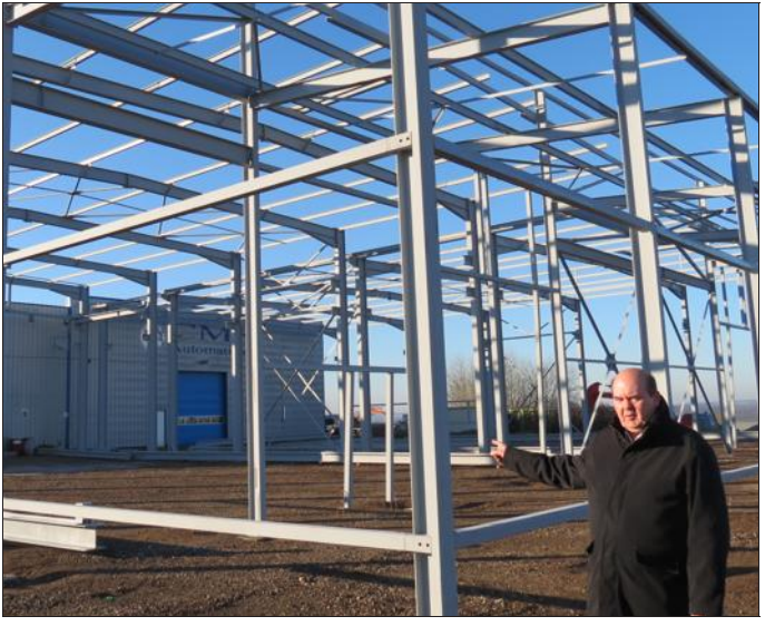
Les travaux d'agrandissement ont commencé, comme le montre Gabriel Buchheit, qui dirige CMS avec son frère Xavier. Photo RL
