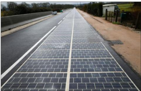
Les cellules photovoltaïques sont encapsulées dans une résine et les panneaux ainsi réalisés sont collés sur la chaussée. Photo AFP
