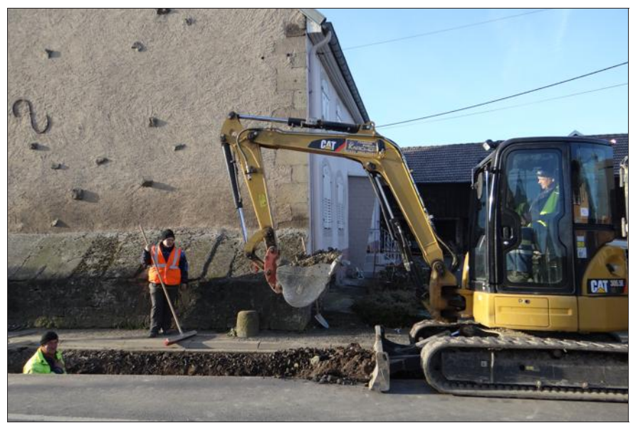
La circulation se fait de manière alternée durant les travaux. PHOTO DR.
