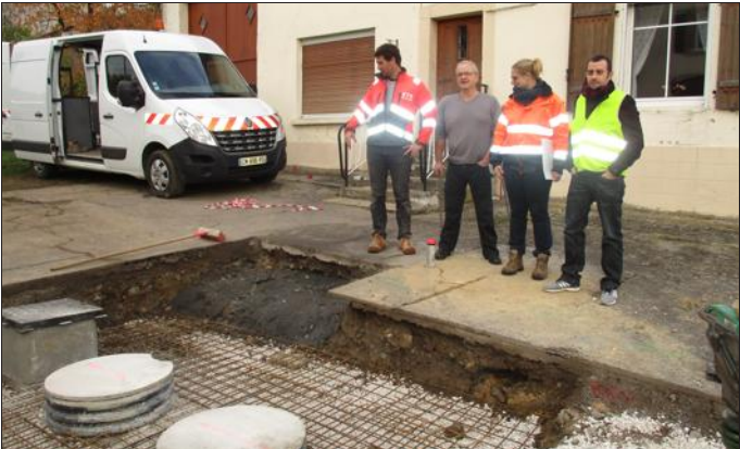
Chaque jeudi, les responsables suivent l'avancement des travaux. Photo RL
