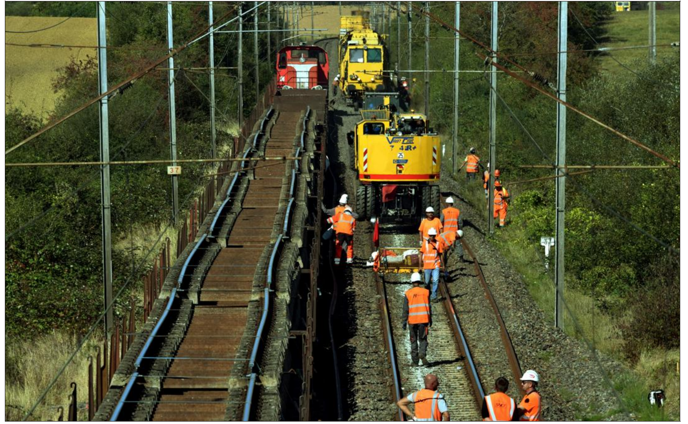
La Région tire la sonnette d'alarme : quelque 700 km de lignes voyageurs seraient en mauvais état et nécessiteraient d'importants travaux. Photo archives RL
