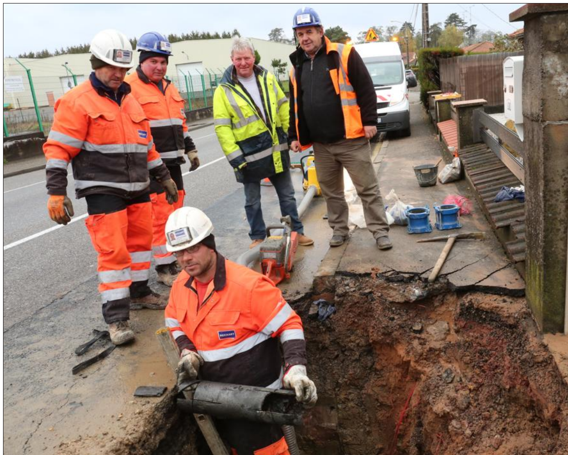
Hier au petit matin, Jacques Crouet, patron de l'entreprise Reichart, et trois de ses spécialistes, étaient sur le terrain rue de Bellevue pour réparer la conduite. Ils ont été rejoints par Mario Schmitt, technicien du service des eaux de la ville.
