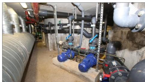
Des moteurs et des souffleurs permettent de créer les bulles ou le contre-courant de la rivière.
