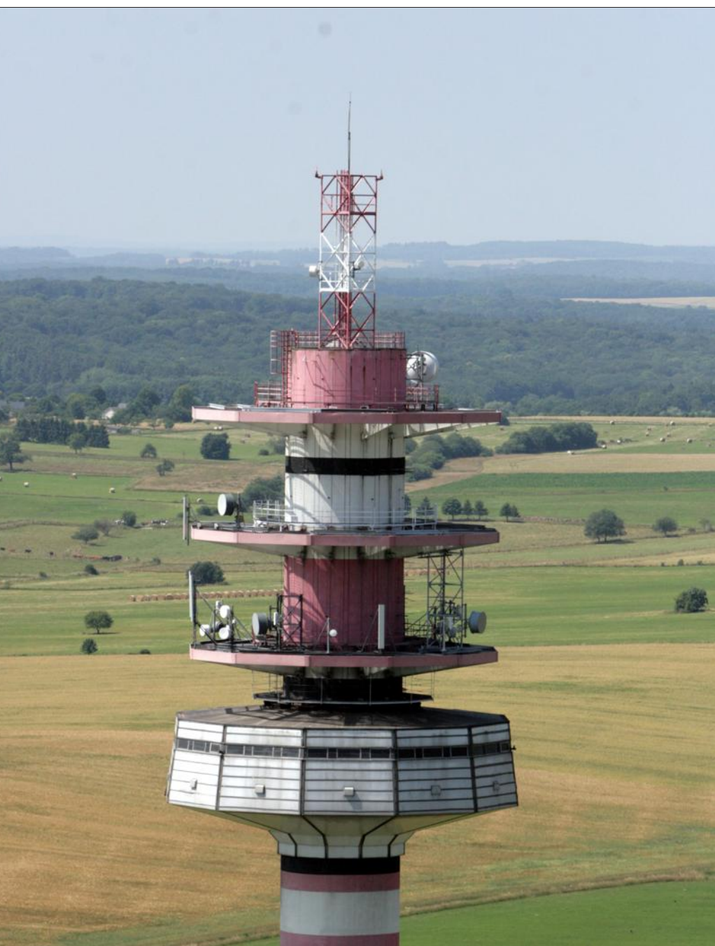
Des travaux de modernisation effectués en juillet sur le relais de Rhodes semblent à l'origine du problème récurrent. Mais pour l'heure, aucune solution n'est trouvée par l'opérateur. Photo Laurent MAMI
