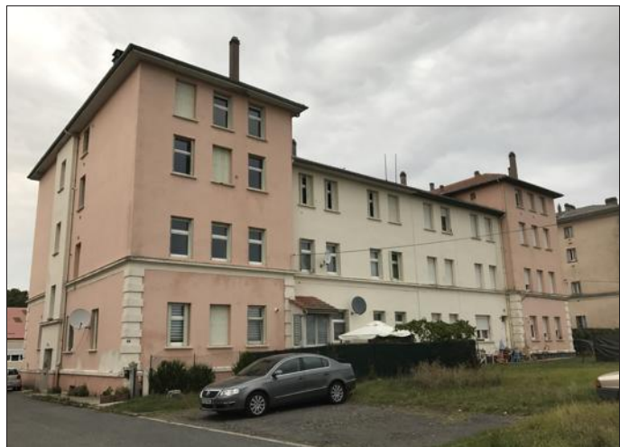
L'immeuble morhangeois semble parfaitement salubre mais abrite un appartement à l'état sanitaire indécemment. Photo RL
