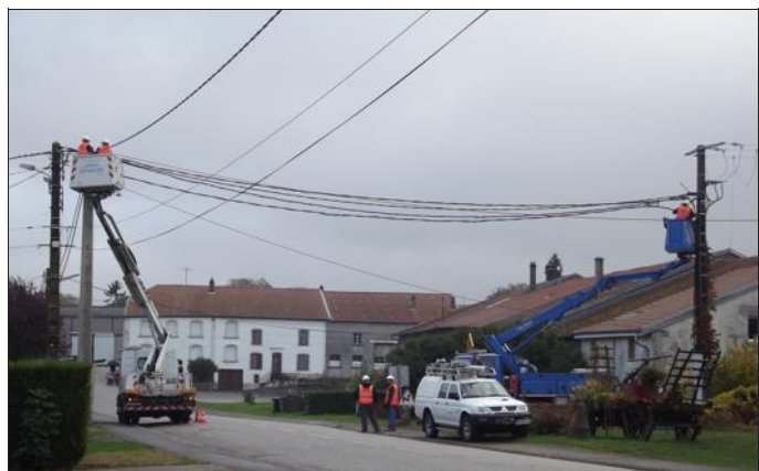
Marthille a connu dernièrement de nouvelles constructions. Afin d'apporter un confort aux abonnés, le fournisseur a procédé à un renforcement du réseau électrique. Le petit-déjeuner s'est fait à la bougie en raison d'une coupure généralisée pendant une matinée complète. Photo RL
