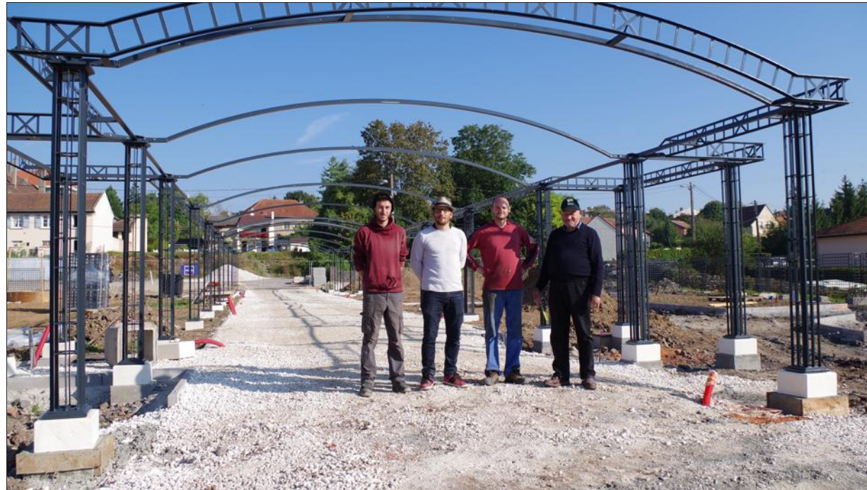
La pergola de 42 mètres est au centre du parc. Des fils de métal la recouvrent afin de permettre à la végétation d'y grimper. Photo RL
