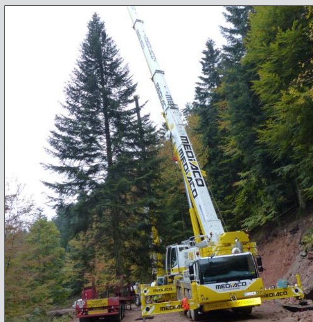
Deux grues ont été utilisées pour le déménagement du beau spécimen sélectionné par la Ville de Strasbourg. Photo RL
