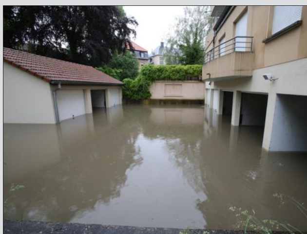
Les fortes pluies de début juin ont causé de nombreux dégâts dans plusieurs communes du secteur. Photo d'archives RL
