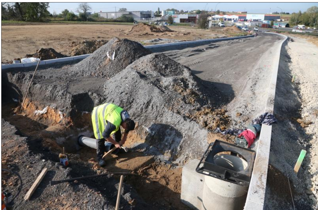
Dans le secteur Arbre Vert de la Zac Louvois, les travaux portent sur l'installation des différents réseaux. Photo Laurent MAMI
