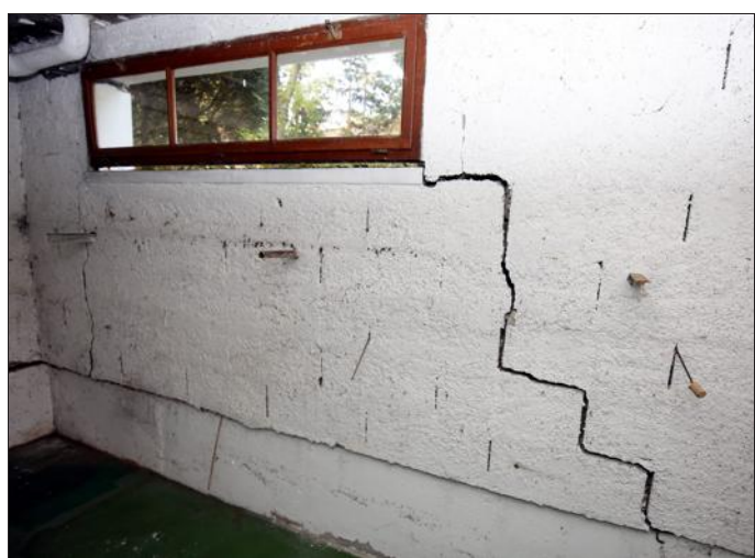
Il faudra attendre le rapport de l'expert pour savoir si ces fissures sont liées ou pas à la sécheresse. Photo Marc WIRTZ
