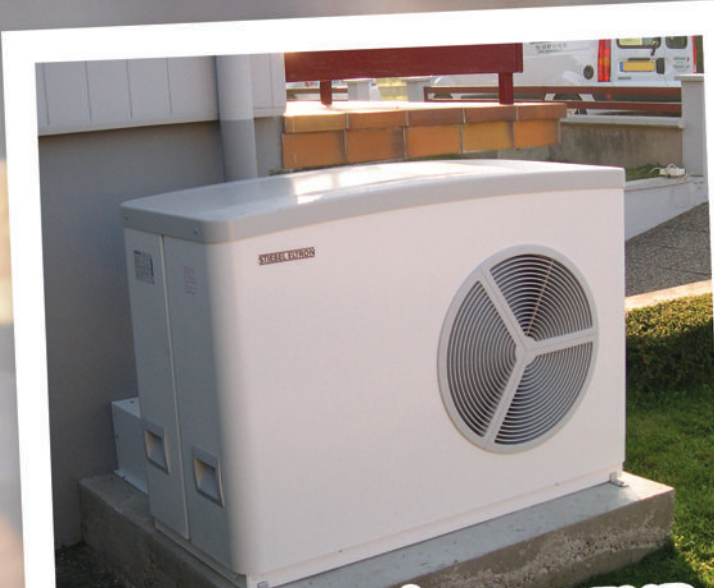
LA POMPE À CHALEUR
